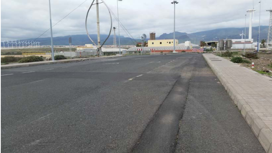
▲ vista del vial existente de trazado recto de acceso al Puerto de Arinaga
